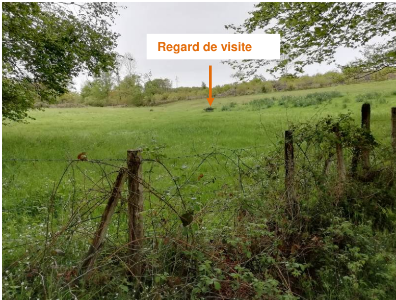
Photo n°6 : Vue du PPI depuis l'aval
