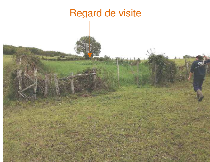
Photo n°12 – Vue du PPI depuis l'aval
