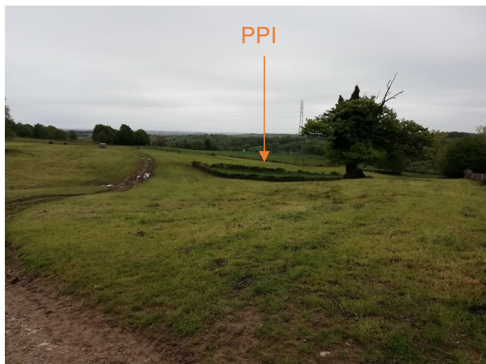
Photo n°11 – Vue du PPI depuis l'amont
